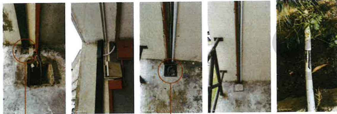
Membekal dan memasang metal/G.I junction box cover min. 6"x6".
