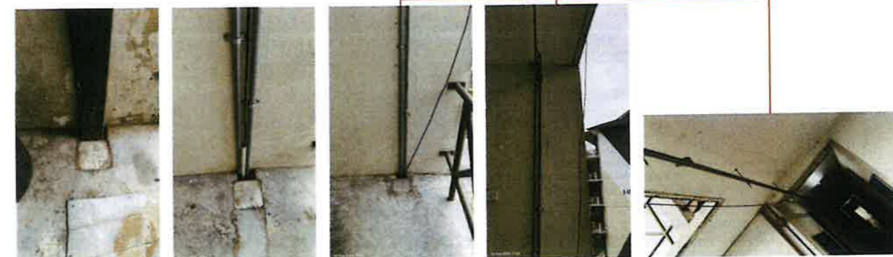
Membekal dan memasang conduit heavy duty uPVC min. 20mm.
