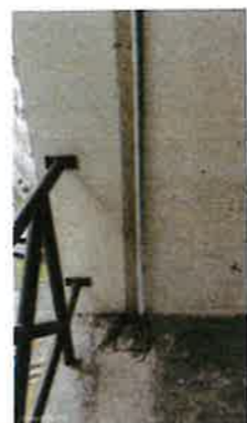
Membekal dan memasang stainless steel/metal/G.I trunking.
